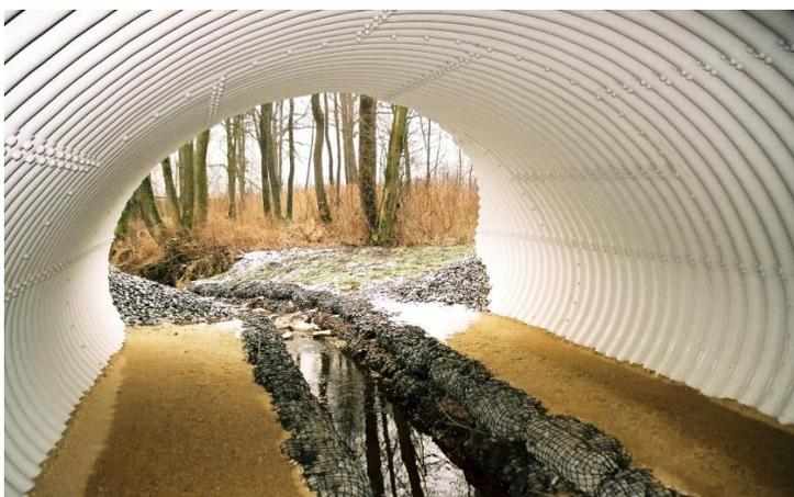
Abbildung 3: Beispielbild Wellstahldurchlass
