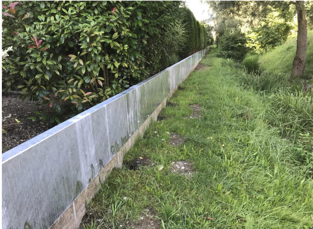
Abbildung 3 Provisorische Mauererhöhung im Bereich der Mühlebachsiedlung zwecks Gerinnekapazitätserhöhung (Gruner, August 2021).
