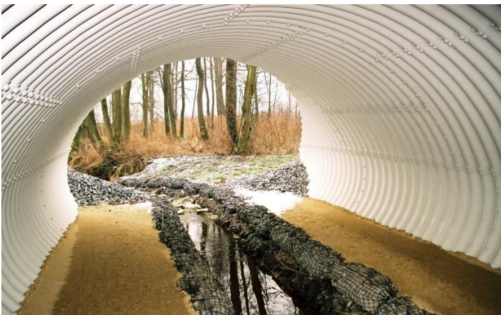
Abbildung 3: Beispielbild Wellstahldurchlass
