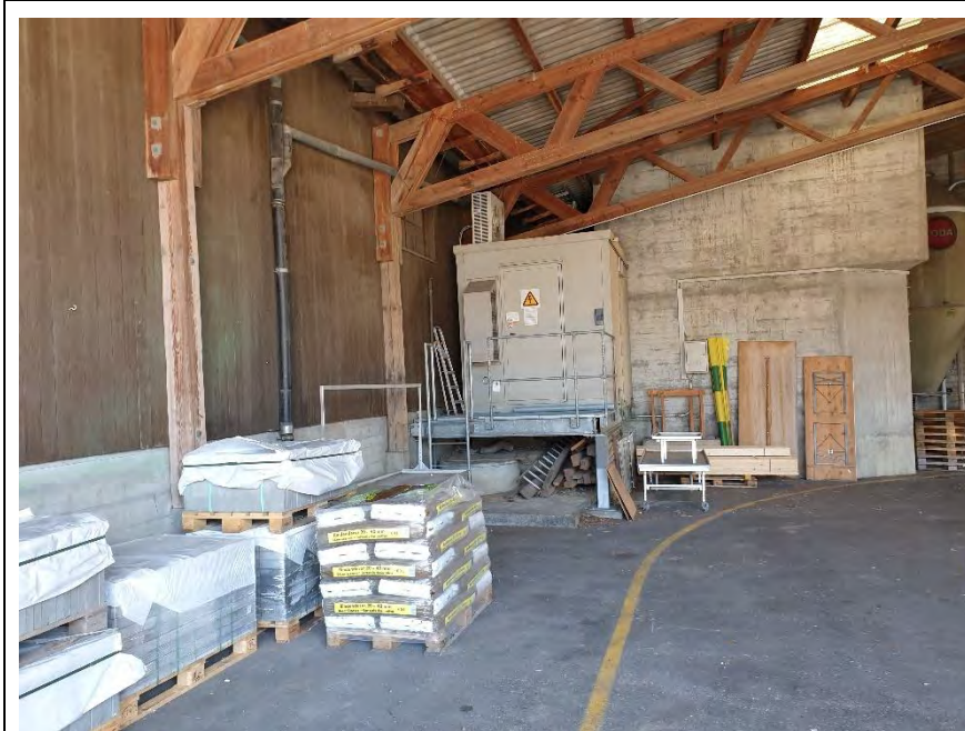
Foto 9: Lage ehemaliger Heizöltank (20'000 l) an der Südseite des Silos (23.03.2021)
