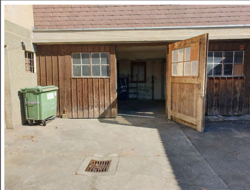
Foto 7: ehemaliger Waschplatz mit Ableitung (23.03.2021)
