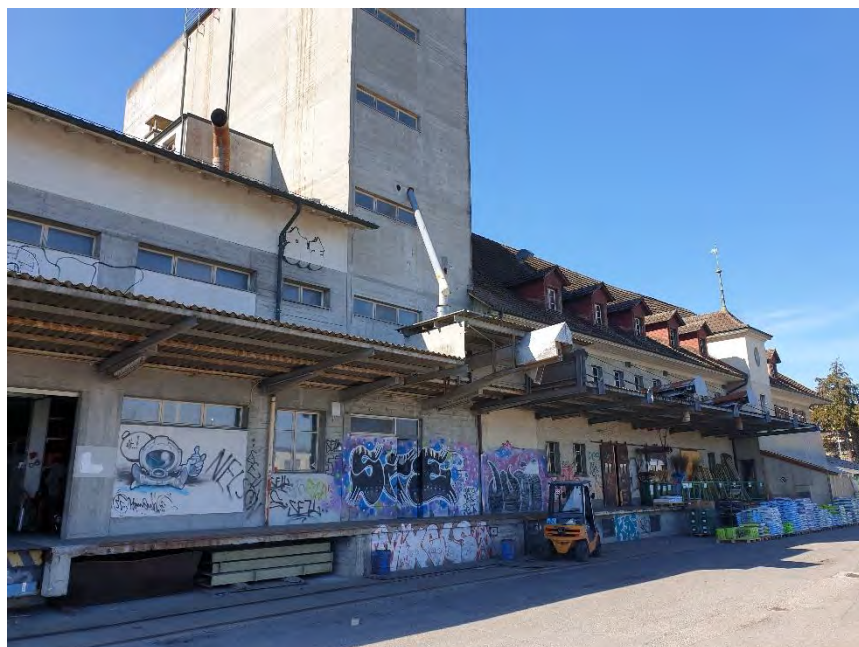
Foto 13: Lagerhallen und Siloturm, Blickrichtung Südwest (23.03.2021)
