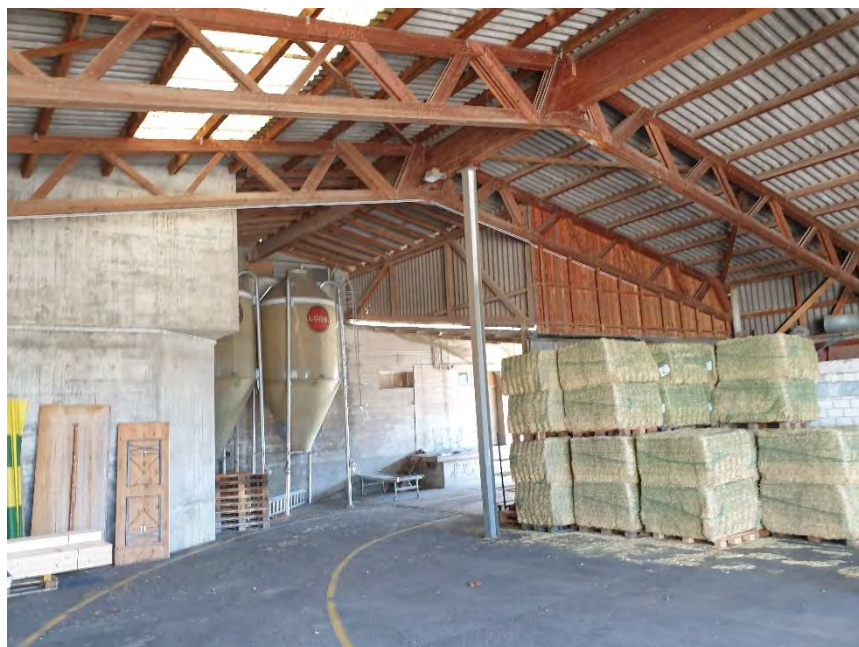
Foto 8: Demontable Anbauten an der Südseite des Silos und der ostseitigen Lagerhallen (23.03.2021)
