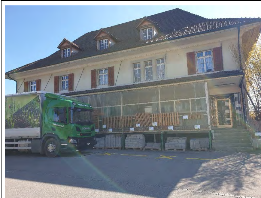
Foto 12: Hauptgebäude mit Verkaufsrampe, Blickrichtung Ost (23.03.2021)
